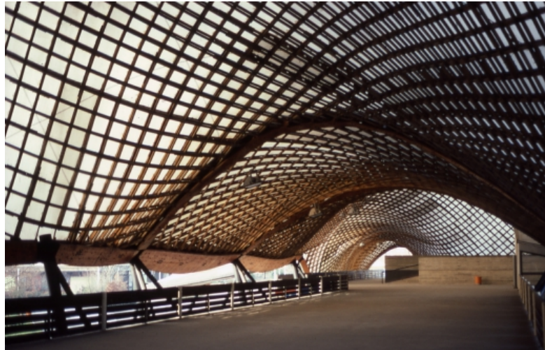
Frei Otto: Multihalle in Mannheim. Foto: © Werkarchiv Frei Otto im Südwestdeutschen Archiv für Architektur und Ingenieurbau (saai)
